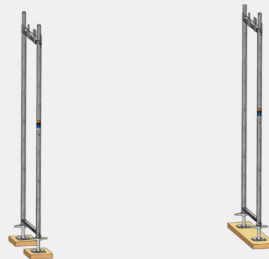
Рис. 6: Монтаж первой секции лесов: вертикальные рамы
