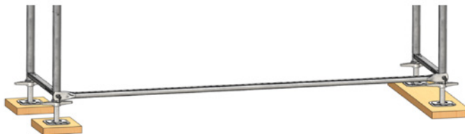
Рис. 7: Монтаж первой секции лесов: продольный ригель
