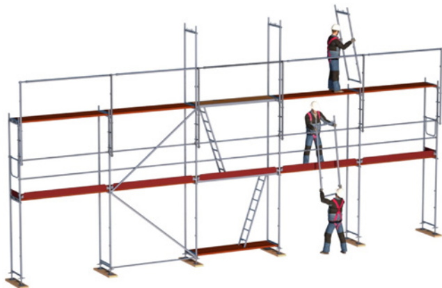
Рис. 30: Монтаж яруса лесов под защитой МЗП
