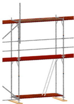
Рис. 26: Монтаж первой стойки МЗП
