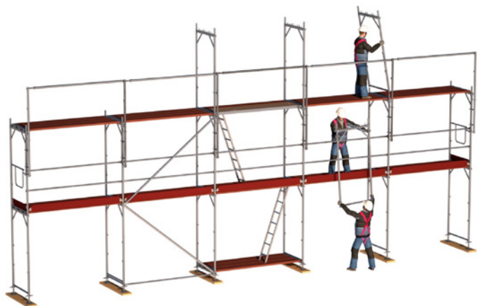
Рис. 30: Монтаж яруса лесов под защитой МЗП
