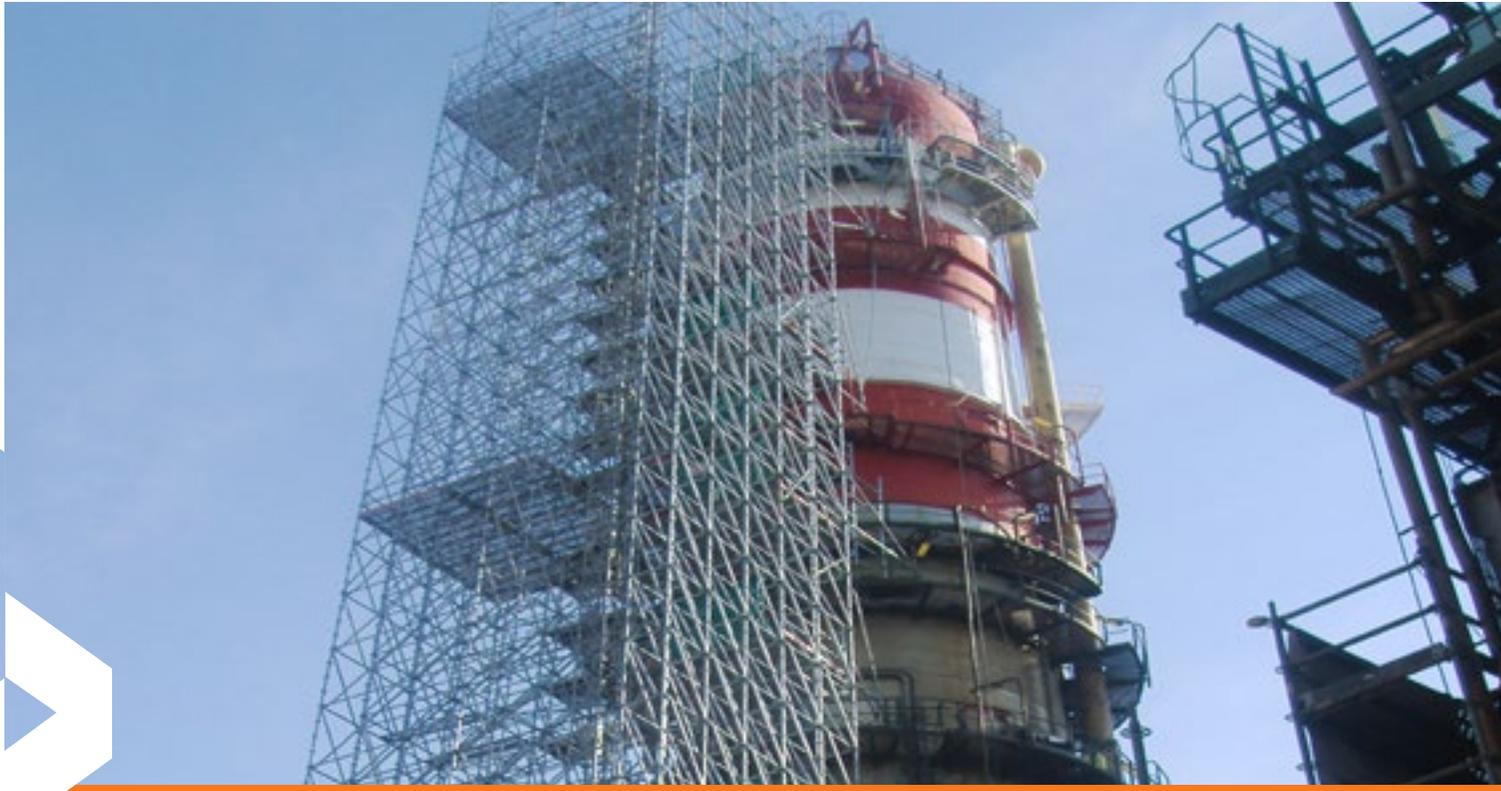
**Repsol-Raffinerie in Spanien.** Die Montage des 90 Meter hohen RINGSCAFF-Gerüsts für Sandstrahlarbeiten in der Raffinerie in Tarragona war eine echte statische Herausforderung. Die Schwierigkeiten, die sich durch die Temperaturschwankungen in der Kolonne, die erhöhte Windlast durch die Schutzplanen und den anfallenden Sand ergaben, wurden durch eine sorgfältige Planung der Verankerung, eine spezielle Konfiguration und perforierte Stahlbohlen gelöst.
