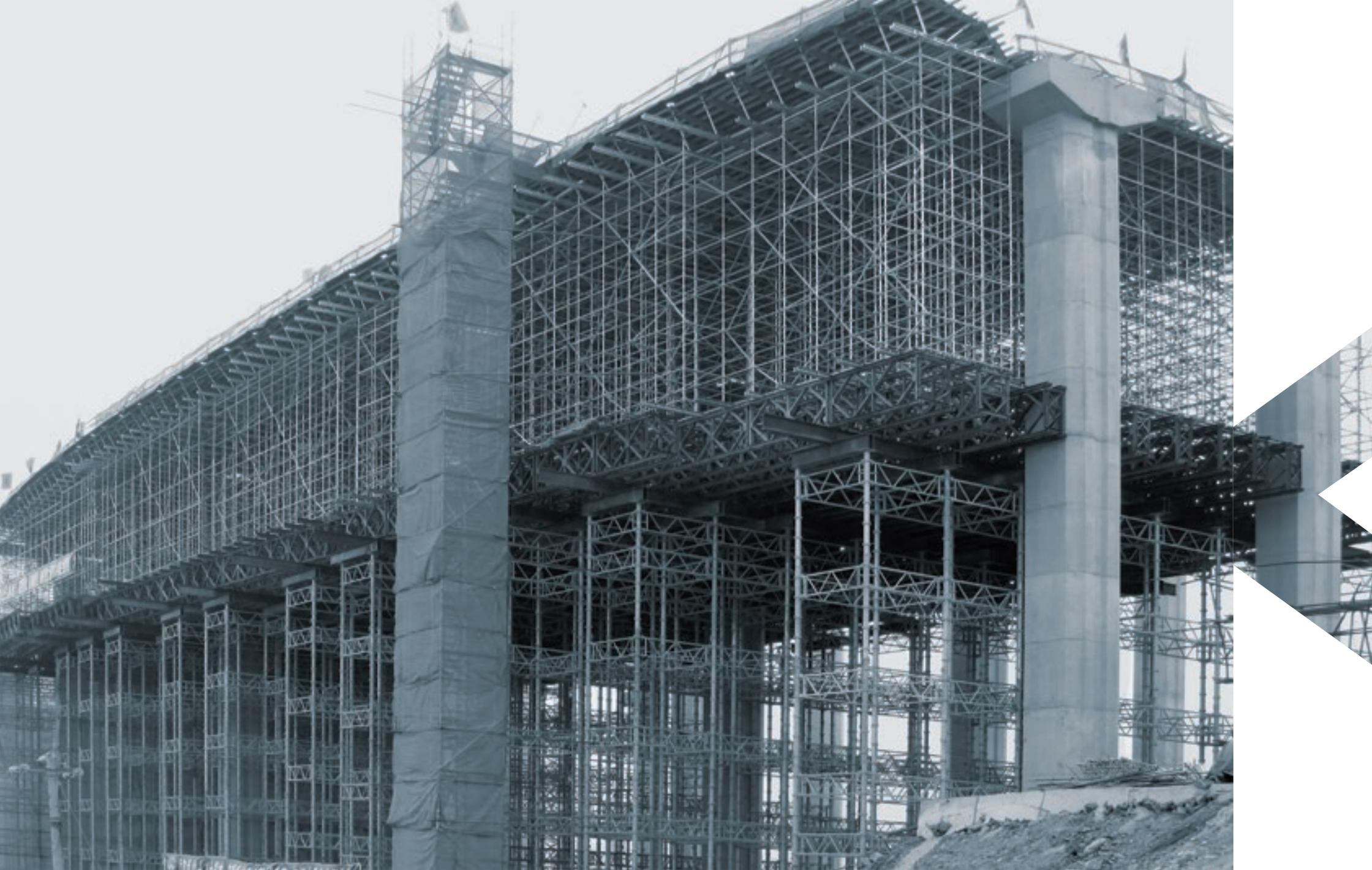
**Guilong-Autobahn in China.** Für den Bau der 12 km langen Schnellstraße in der Provinz Guizhou wurden eine Million Kubikmeter SPS-, Duralok- und SBS 135-Material verwendet. Für das Projekt mussten spezielle Abstützkonstruktionen angefertigt werden.
