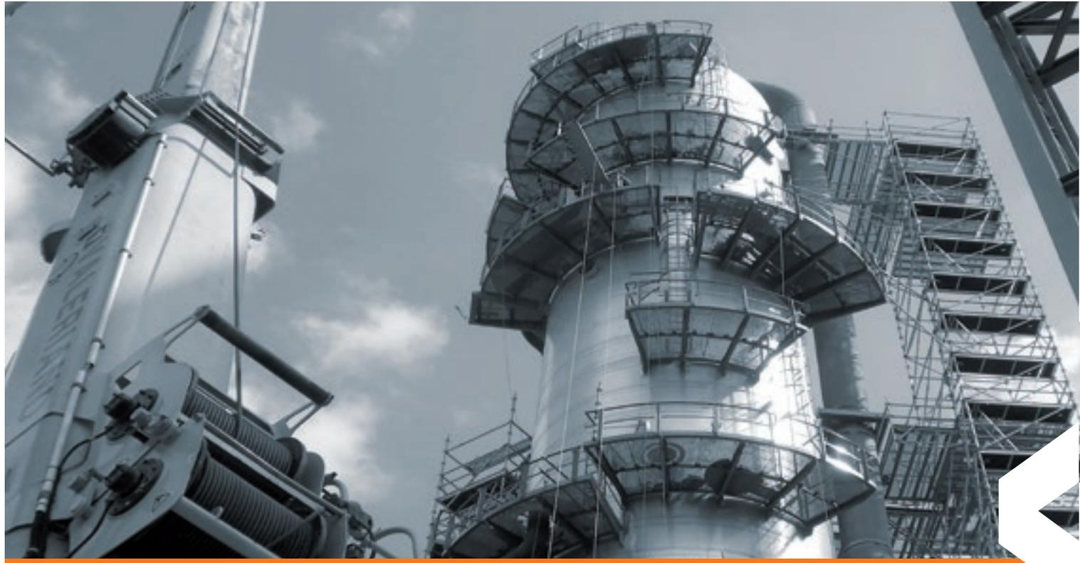
**Europoort Kraftwerk in den Niederlanden.** *Das multidirektionale RINGSCAFF-System war ideal für die Arbeiten an dem Kraftwerk in Rotterdam. Dank seiner Flexibilität konnte das Gerüst an die schwierige Form des Objekts angepasst werden.*
