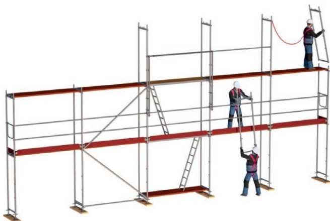
Рис. 35: Монтаж с СИЗ от падения с высоты на верхнем ярусе лесов
