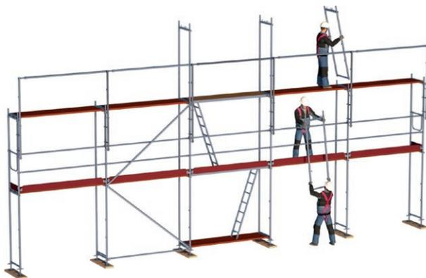
**Bild 30: Montage der Gerüstebene im Schutze des MSG.**
