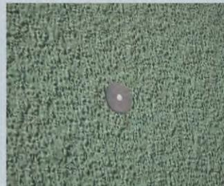
**PU-Stopfen** – durch die Isolierung und Abdichtung der Ankerstelle wird die Kälte-Wärme-Brücke der Fassade unterbrochen.
