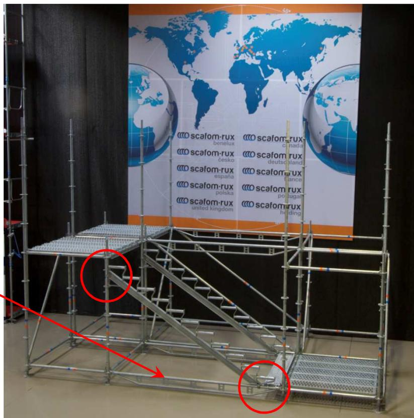
7. Böden montieren und gegen Abheben sichern.
