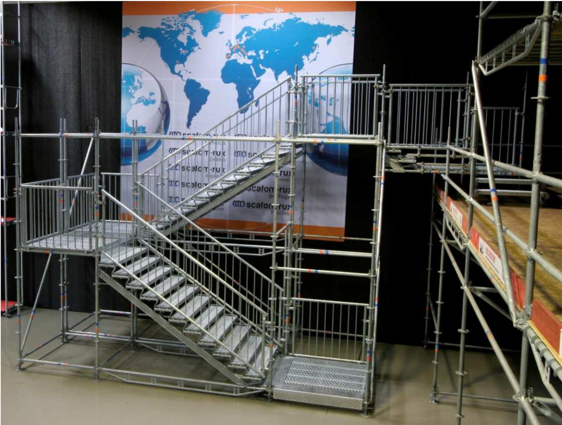
Für die Montage angehängter Übergänge, Podeste oder Treppen zu den nebenstehenden Gebäuden verweisen wir auf das Rux- Blaues Blatt „Belastbarkeit von verstärkten Ringscaff- Riegeln“ sowie die aktuelle Aufbau- und Verwendungsanleitung für das jeweilige Traggerüst.
