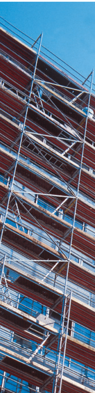
Abbildung 6.1: Zugang zu höheren Gerüstlagen über Durchstiegstafeln mit Leitergang
