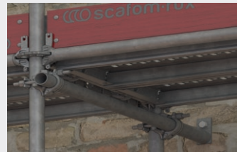
Bild 6.2c: Beispiel Verankerungsüberprüfung
