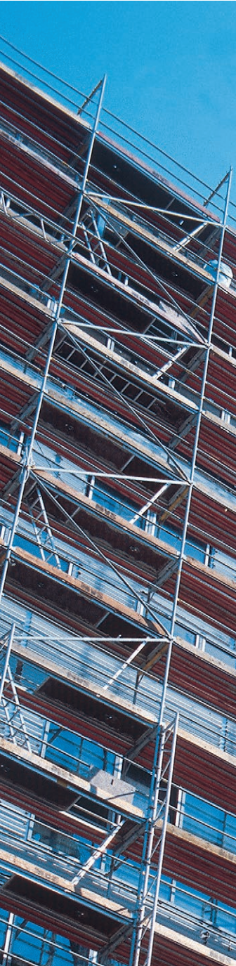
Abbildung 6.1: Zugang zu höheren Gerüstlagen über Durchstiegstafeln mit Leitengang
