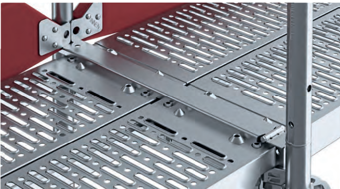
Bild 36 Sichern von Rundrohr-Belägen gegen Abheben
