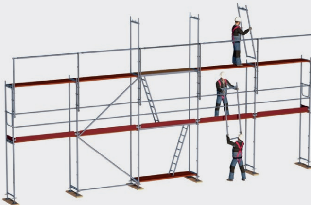
Bild 25: Beispiel für den Vertikaltransport von Hand.
