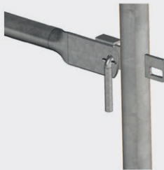
Bild 12: Knebelgeländer montieren und verriegeln.
